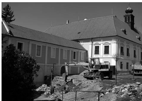
Terénní úpravy po demolici šatlavny (dokončování v roce 2015)
