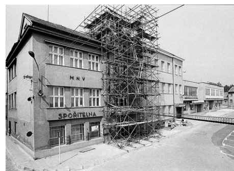
Instalace věžních hodin na budovu radnice
