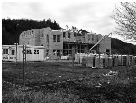
Stavba nové hasičské stanice
