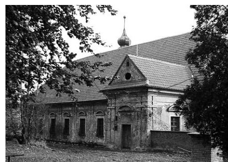
Severozápadní strana zámku v 80. letech (pohled z parku)
