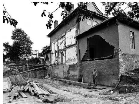
Základy pro přístavbu sokolovny
