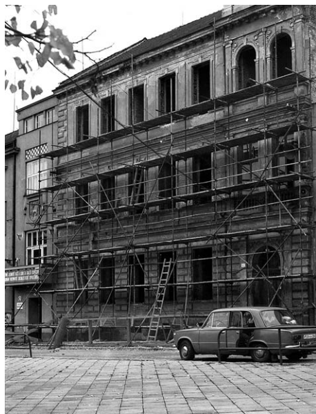
Přestavba budovy školy na ředitelství státního statku
